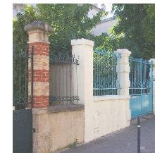
Ils sont traités en pierre de taille à joints réguliers saillant légèrement du mur avec couronnement ouvragé (lisses en pierre de taille), ou en enduit sans saillie sur le mur avec couronnement simple.
