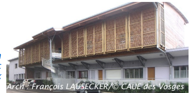
Intégration sur un volume moderne avec un choix de matériaux et de teintes cohérent.
