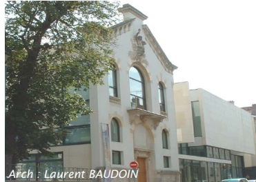
Extension moderne à toiture terrasse.
